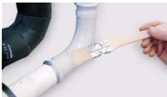
Рис. 37. Покраска соединений и труб праймером.
